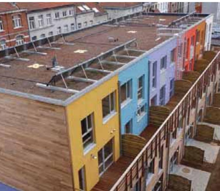
Le projet « l'Espoir » cumule techniques et matériaux durables : ossature bois, isolation en cellulose, panneaux solaires thermiques, toiture végétalisée, ventilation mécanique contrôlée à récupération de chaleur, châssis triple vitrage...
